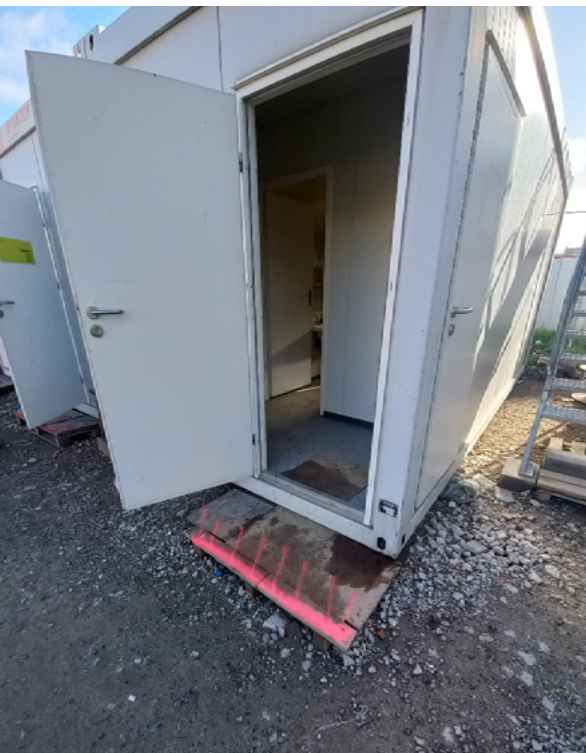
Wrocław Park Zachodni — oznakowanie progów przy wejściach do kontenerów
