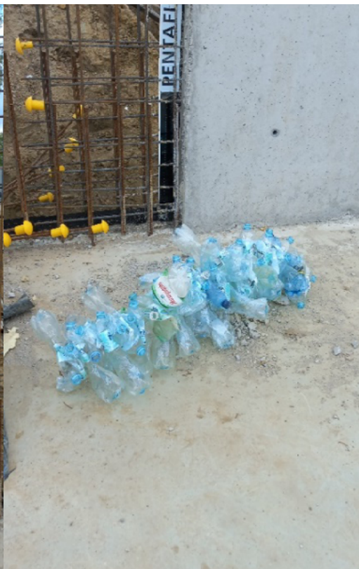
Wrocław Park Zachodni R4R — zabezpieczenia na prętach / schodnia systemowa / segregacja (butelki) / oznakowanie ostrzegawcze wystających elementów
