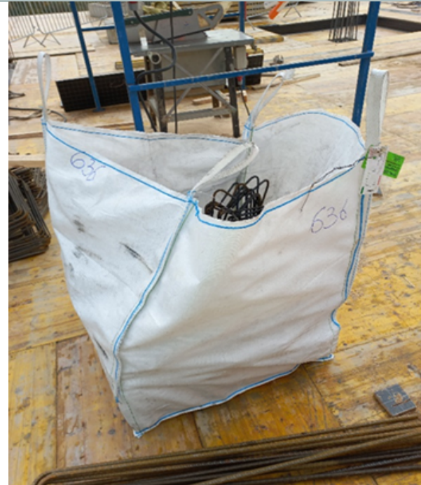
Kraków Brain Park — transport od producenta elementów zbrojenia w workach big-bag
