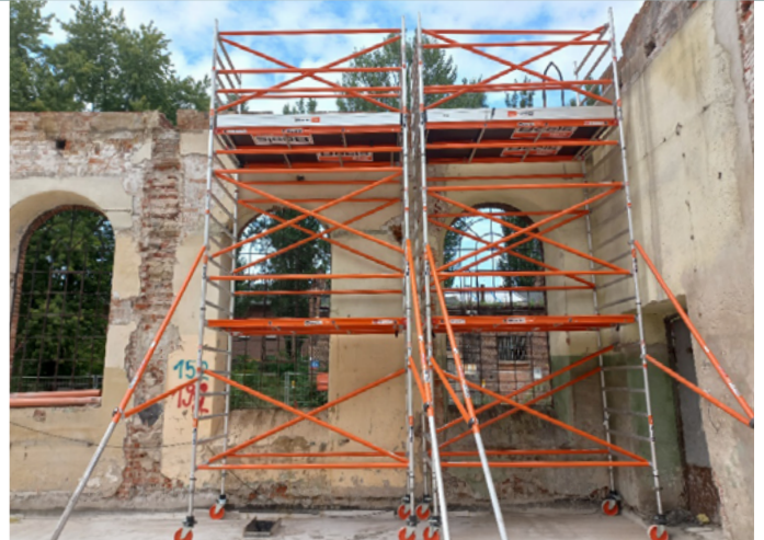
Łódź Fuzja H03 renowacje — kompletne rusztowanie, właściwy stan techniczny, wypory boczne
