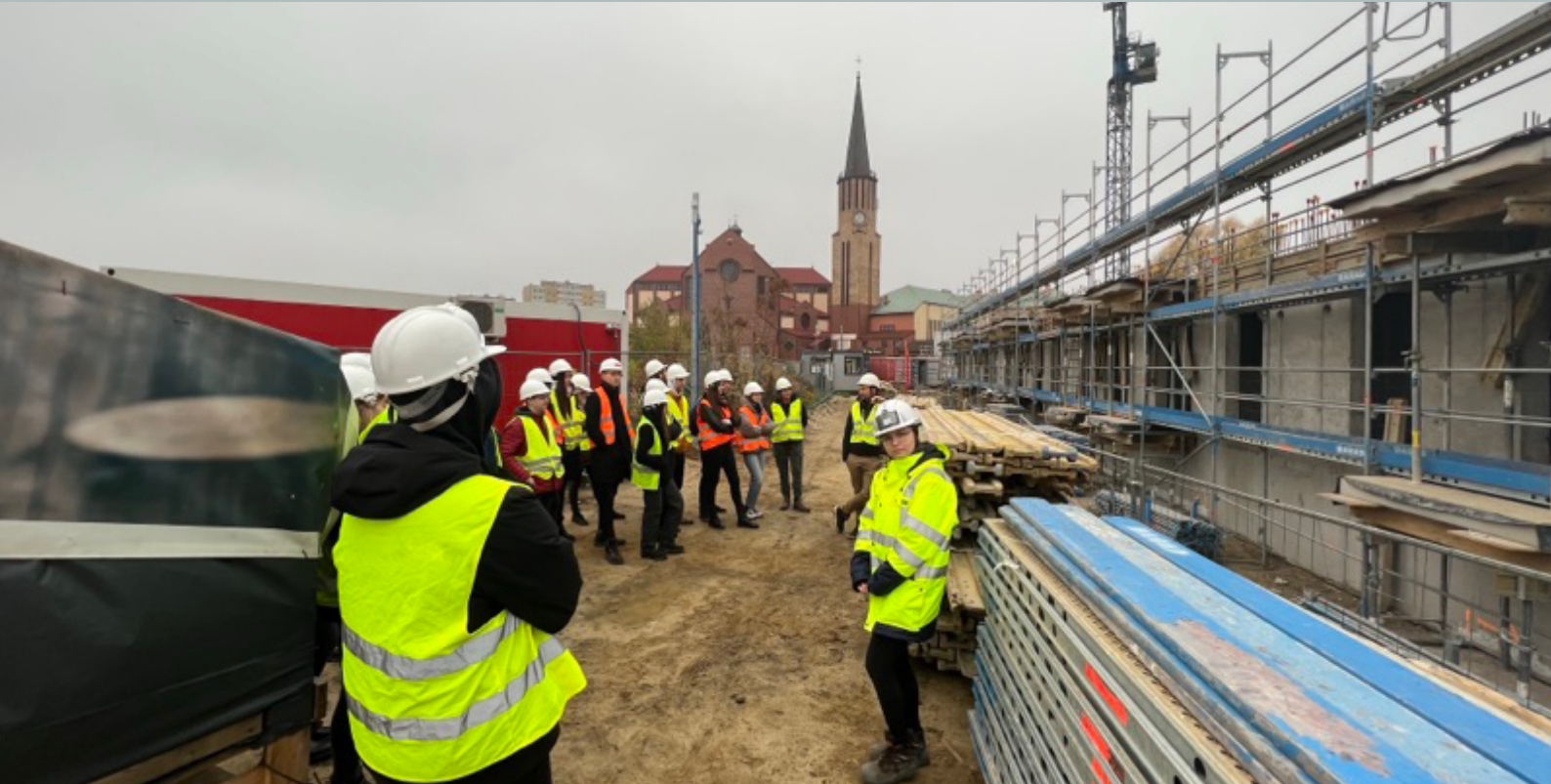
Wizytacja budowy Park Zachodni R4R we Wrocławiu
