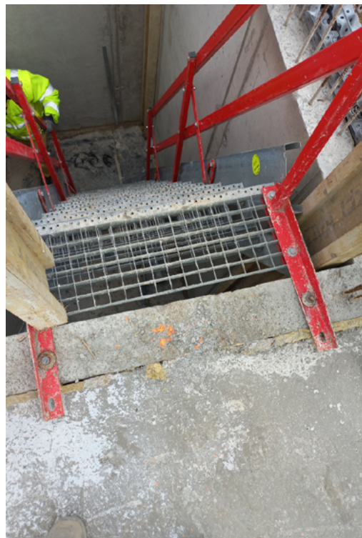
Wrocław Park Zachodni — Schodnia systemowa w szachcie / Podwieszane kable
