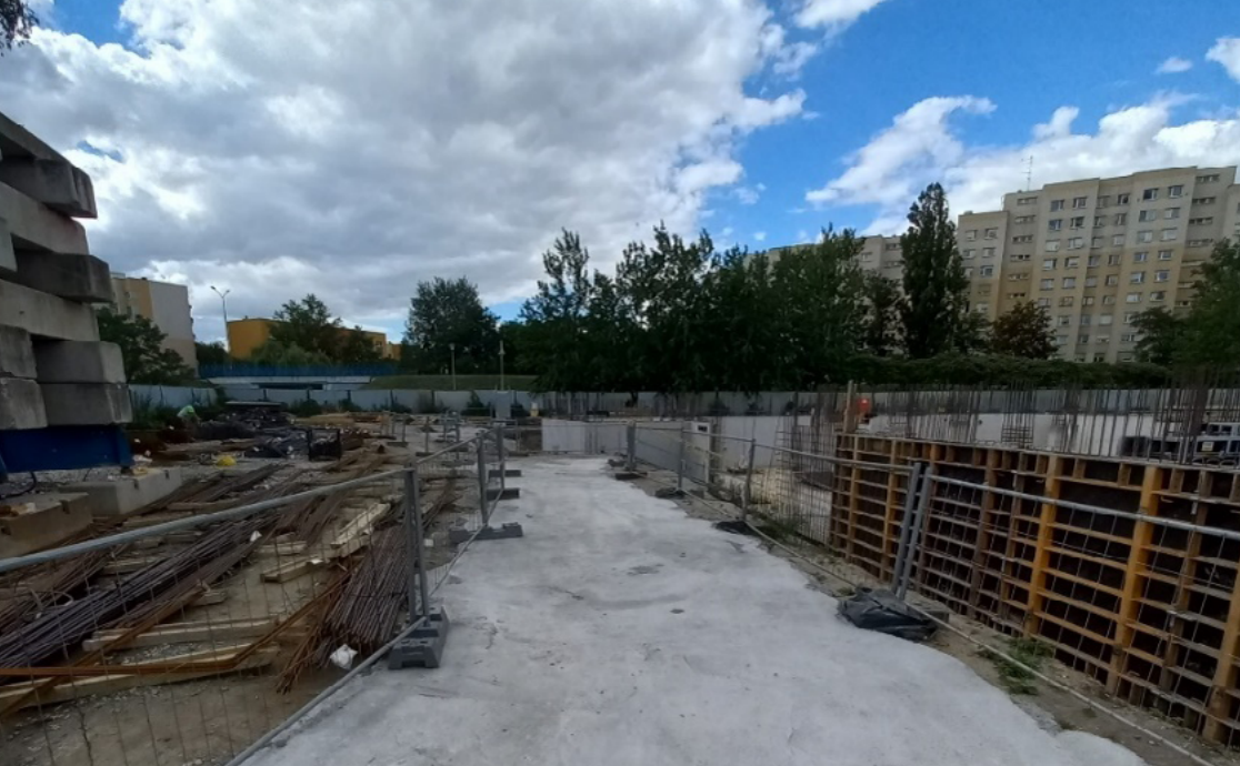
Wrocław Park Zachodni — utwardzone i wyznaczone ciągi komunikacyjne
