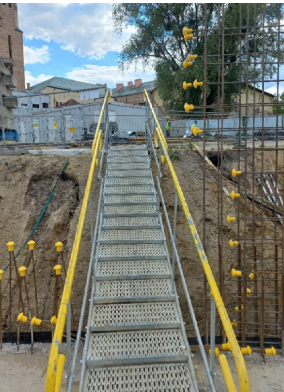
Wrocław Park Zachodni R4R — zabezpieczenia na prętach / schodnia systemowa / segregacja (butelki) / oznakowanie ostrzegawcze wystających elementów
