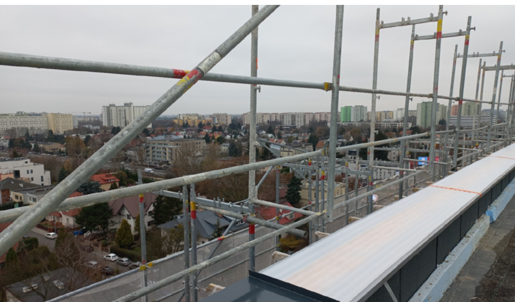
Warszawa R4R Wilanowska - zabezpieczenie atyki rusztowaniem
