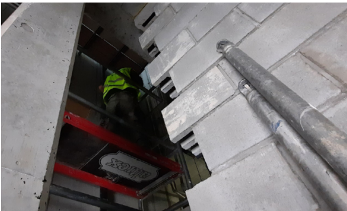
Łódź Fuzja J01 - prace w szachcie z rusztowania
