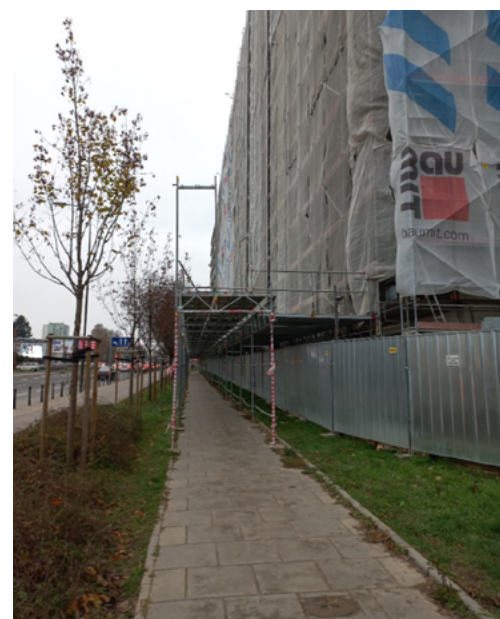
Warszawa R4R Wilanowska - zabezpieczenie strefy publicznej (tunnel)
