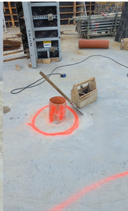
Wrocław Park Zachodni R4R — zabezpieczenia na prętach / schodnia systemowa / segregacja (butelki) / oznakowanie ostrzegawcze wystających elementów
