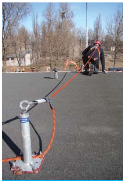
Fot. 21 Urządzenie samozaciskowe na linie poliamidowej rdzeniowej przyłączone do punktu zakotwienia
