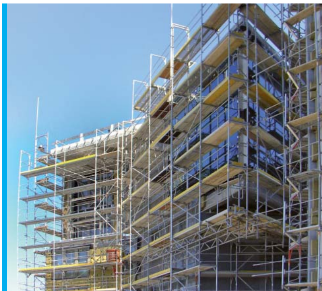
Fot. 37 Rusztowania i podesty robocze
