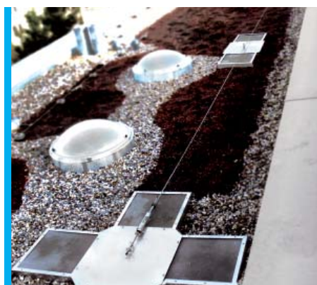
Fot. 33 Bezwładna masa kotwicząca wykorzystana jako punkt pośredni stałego systemu linowego
