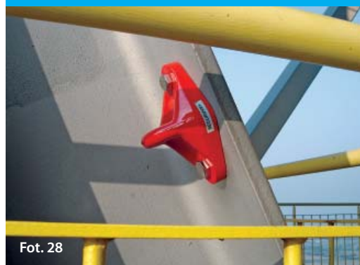
Fot. 26 Słupek dachowy mocowany do stropu kotwami
